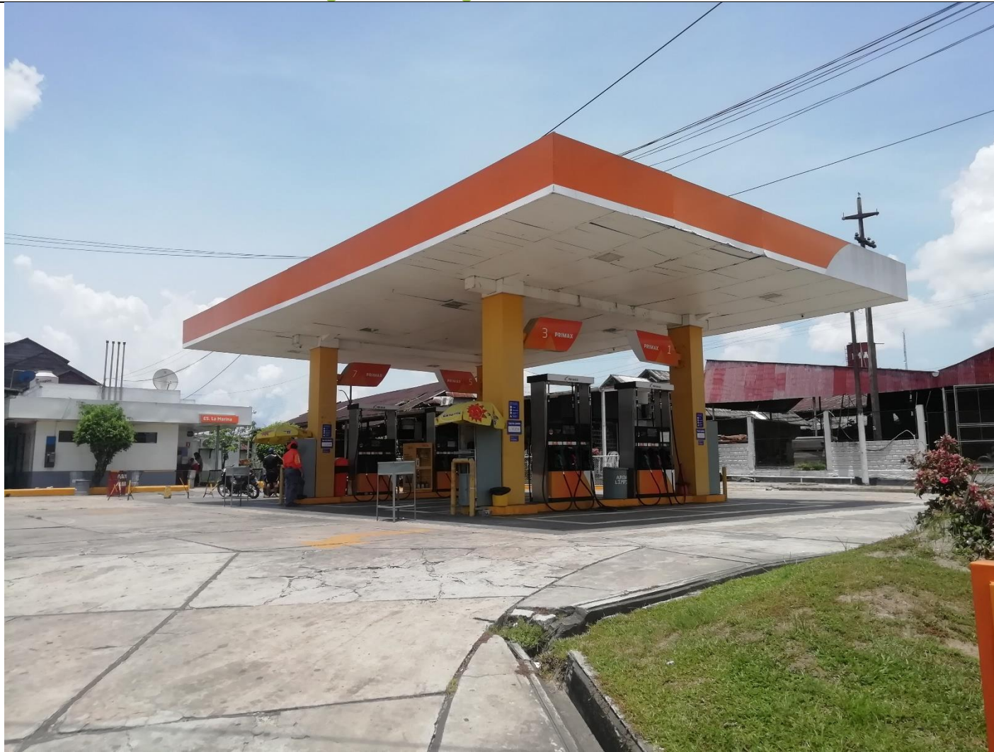
Fotografía 1 Vista general de la E/S La Marina
